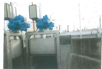
大江堀調整ゲート整備後
