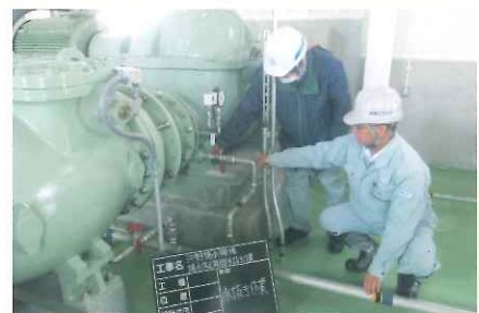
沖野揚水機場水抜き作業 (榊北都プラント)
