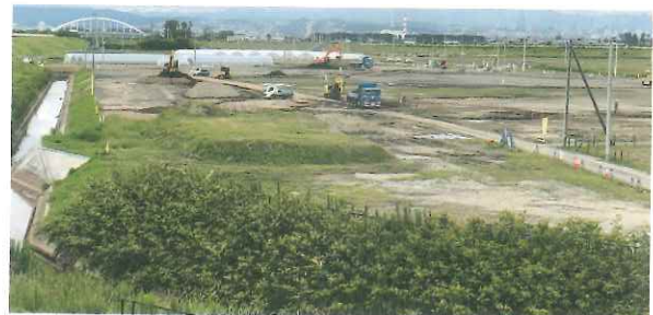
用地造成工事中（令和元年9月現在）
