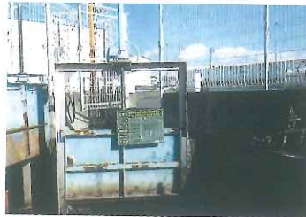
大江堀調整ゲート整備前
